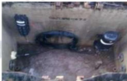
Fig. Vista interior de un pozo con empalmes y cable de reserva.
