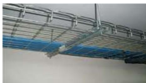
Fig. Bandeja tipo Canasta
