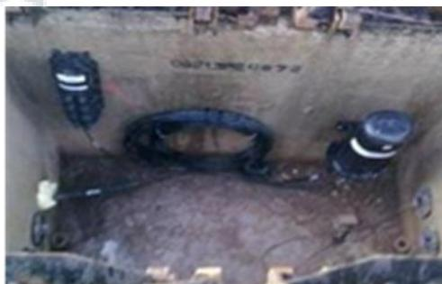
Imagen 22. Vista interior de un pozo con empalmes y cable de reserva.
