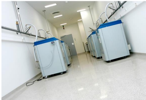
Figura No. 2. DETALLE DE PISOS EPÓXICO.
