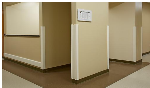
Ángulos de material resistente que garantizan la protección en las aristas de las paredes del edificio. (ver figura arriba)
