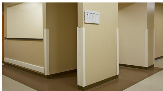
Ángulos de material resistente que garantizan la protección en las aristas de las paredes del edificio. (ver figura arriba)
