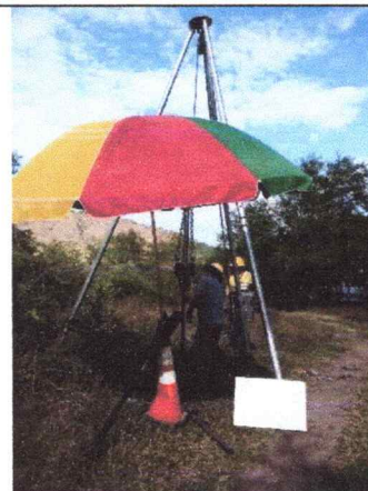
Ubicación y realización de sondeo de exploración S6
