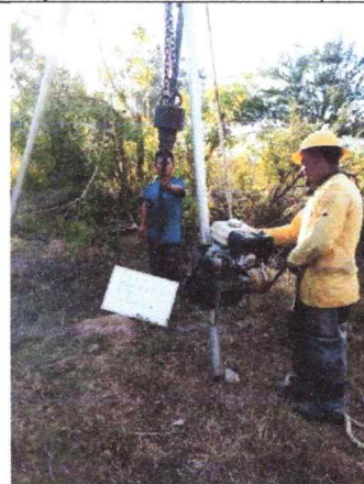
Ubicación y realización de sondeo de exploración S4
