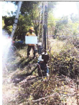
Ubicación y realización de sondeo de exploración S2
